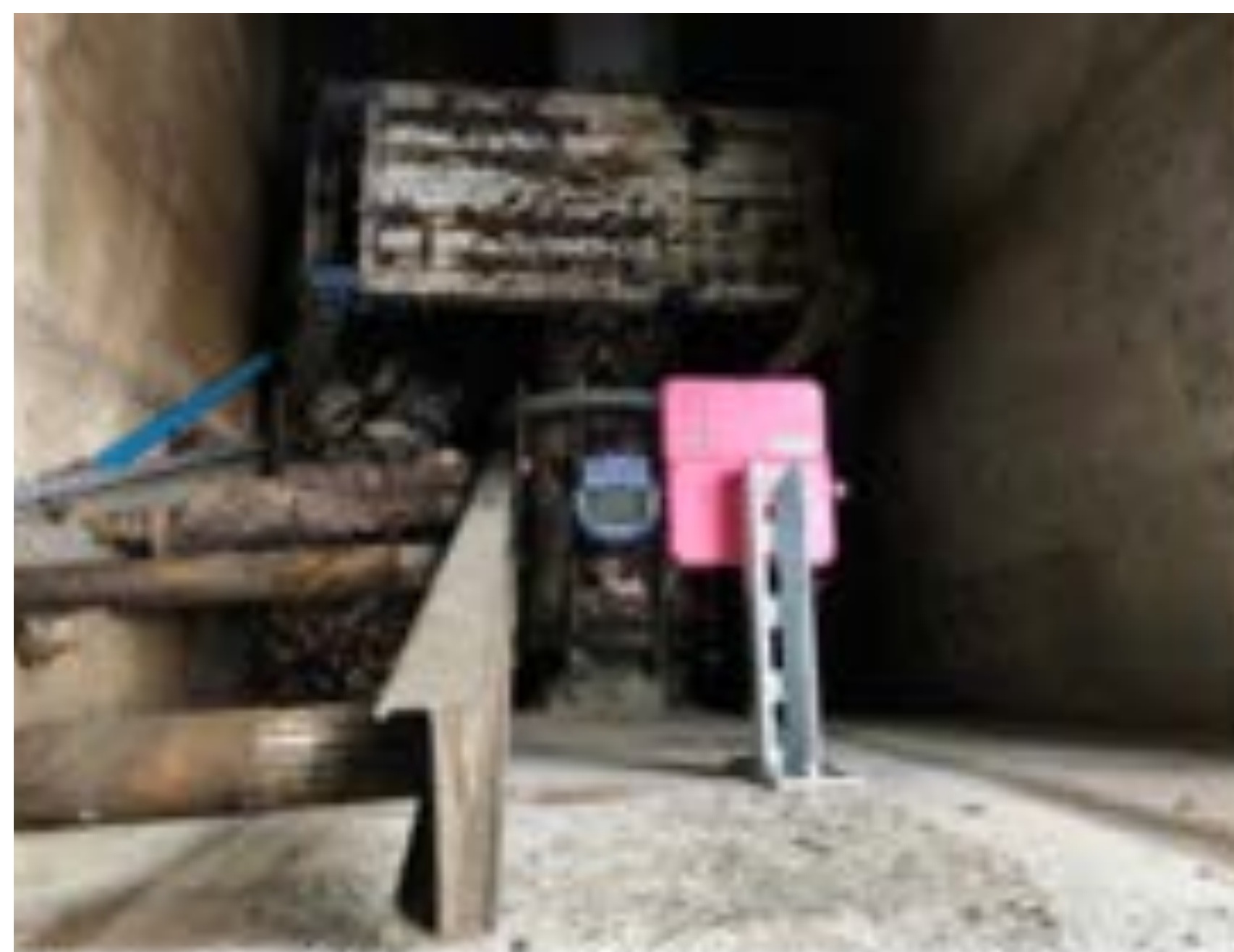
マンホール内
